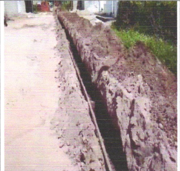
Foto 08: Implantação de sistema de abastecimento
