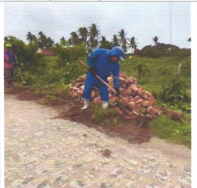
Foto 16: Serviço de limpeza
