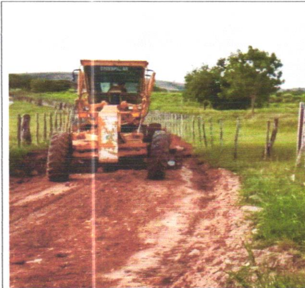
Foto 01: manutenção de estradas
