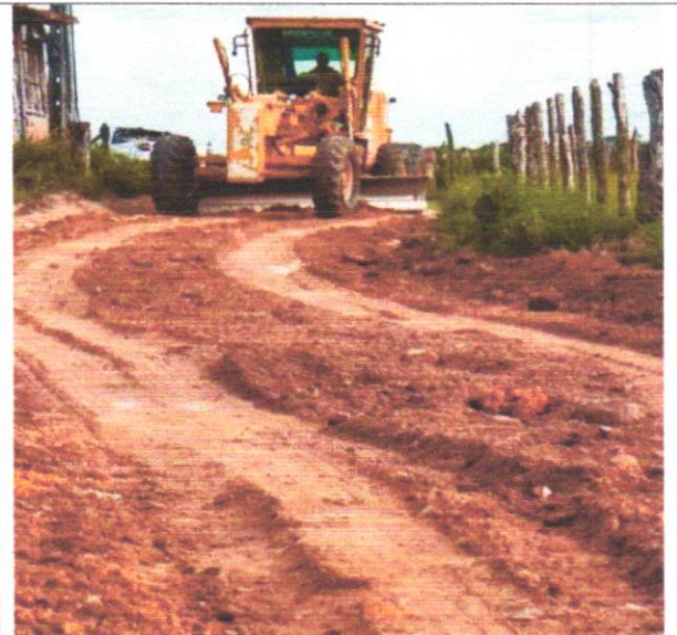
Foto 02: manutenção de estradas
