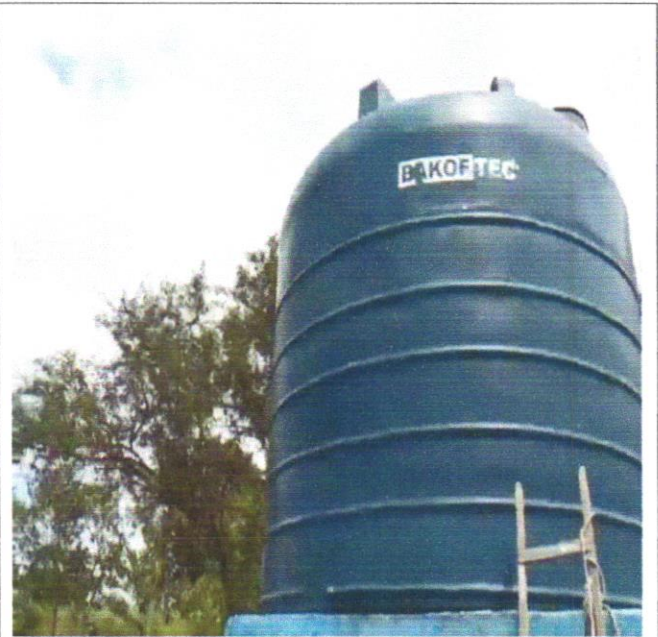
Foto 10: Implantação de caixa d'água
