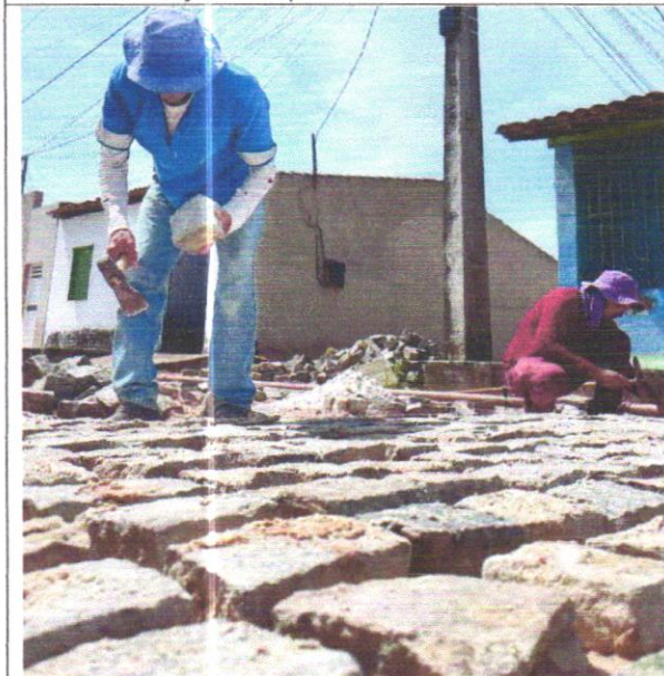
Foto 15: Serviço de manutenção de ruas
