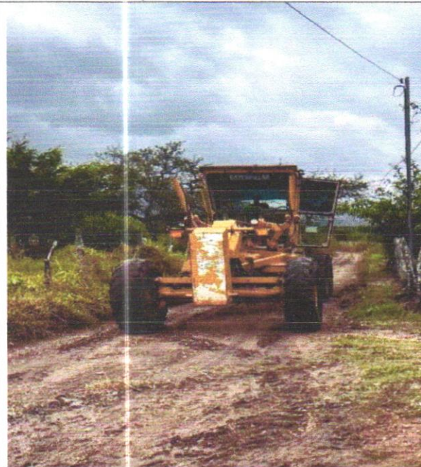
Foto 03: manutenção de estradas
