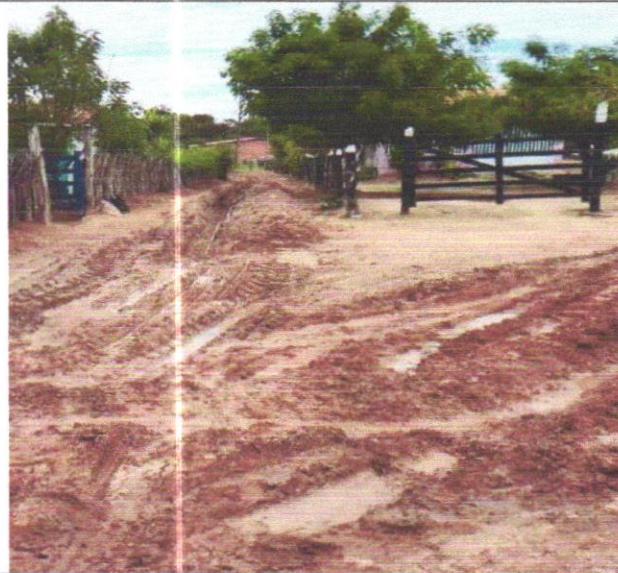
Foto 07: Implantação de sistema de abastecimento
