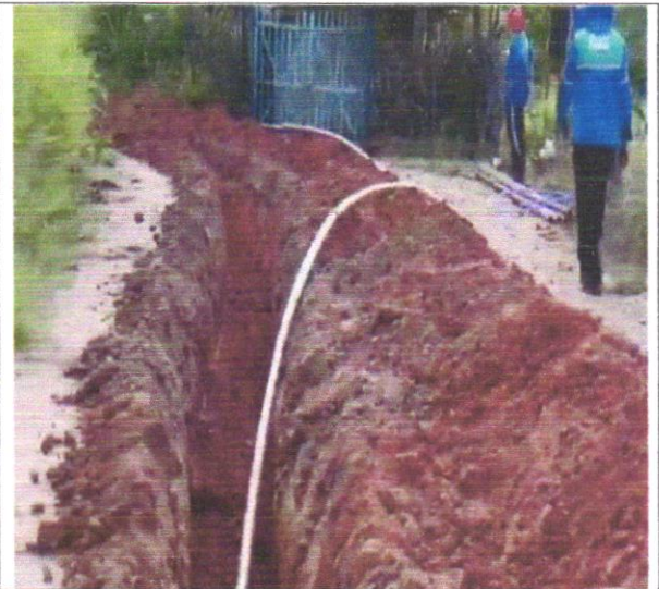
Foto 06: Implantação de sistema de abastecimento
