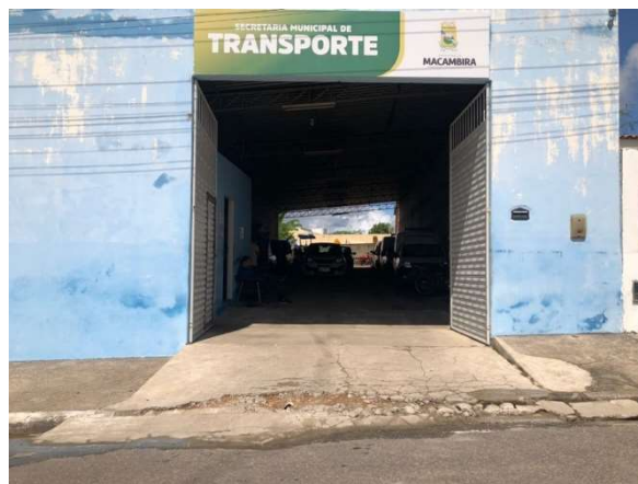
IMAGEM DA FACHADA DA SECRETARIA MUNICIPAL D TRANSPORTE EM 2021
