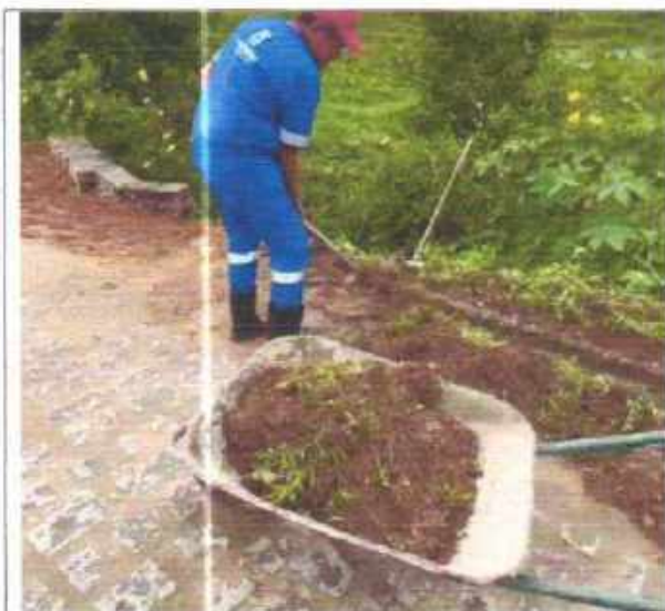
Foto 13: Serviço de limpeza
