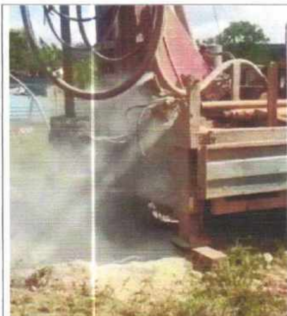
Foto 09: Perfuração de poços artesanais
