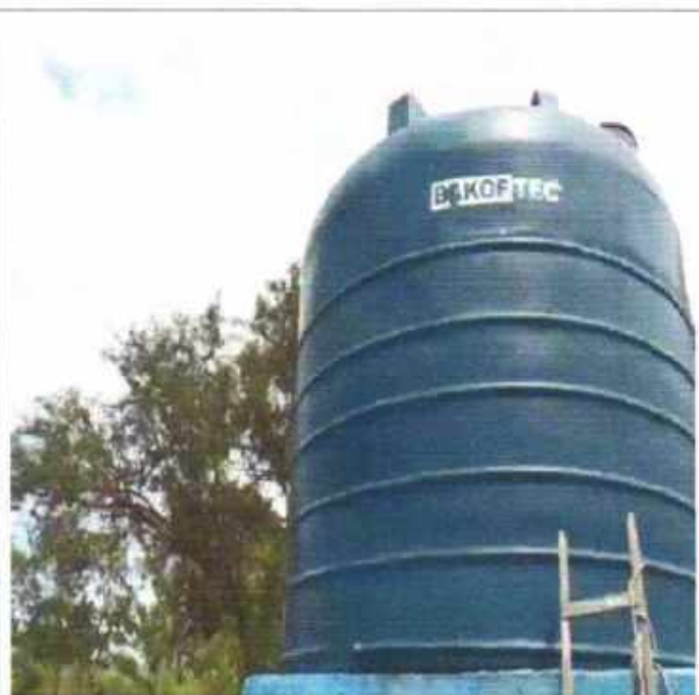
Foto 10: Implantação de caixa d'água
