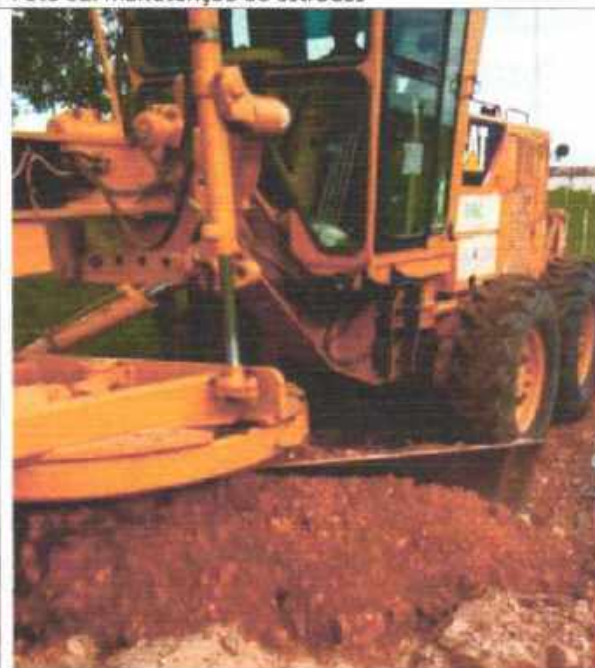
Foto 04: manutenção de estradas
