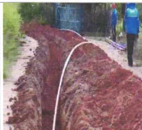
Foto 06: Implantação de sistema de abastecimento
