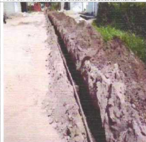
Foto 08: Implantação de sistema de abastecimento
