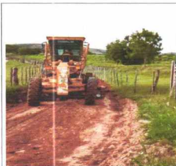
Foto 01: manutenção de estradas
