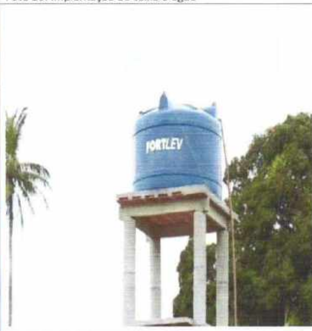
Foto 12: Implantação de caixa d'água
