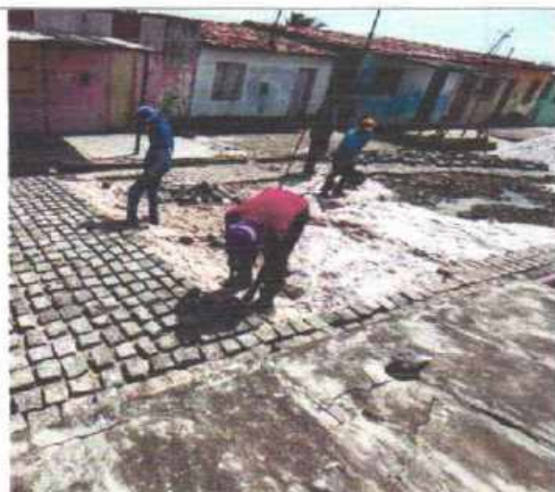
Foto 14: Serviço de manutenção em ruas
