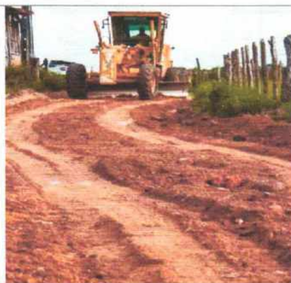
Foto 02: manutenção de estradas
