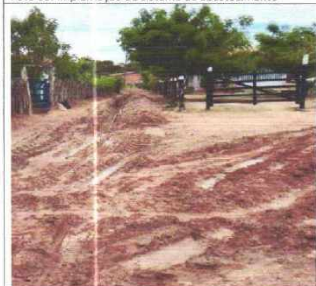
Foto 07: Implantação de sistema de abastecimento
