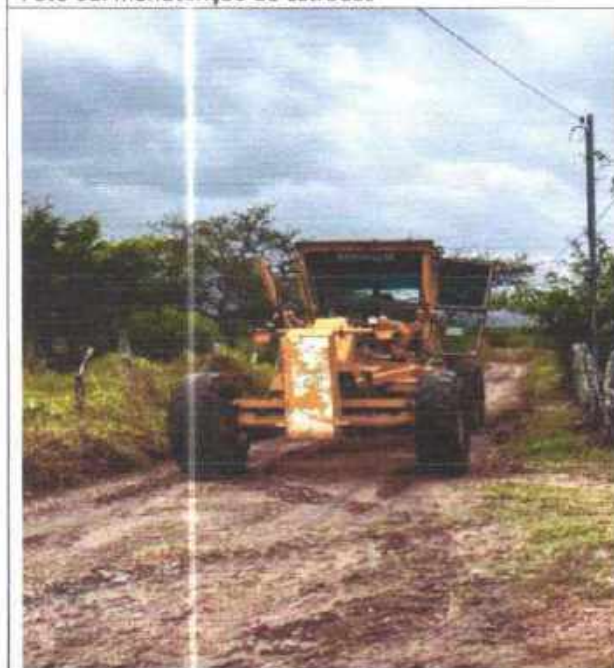
Foto 03: manutenção de estradas
