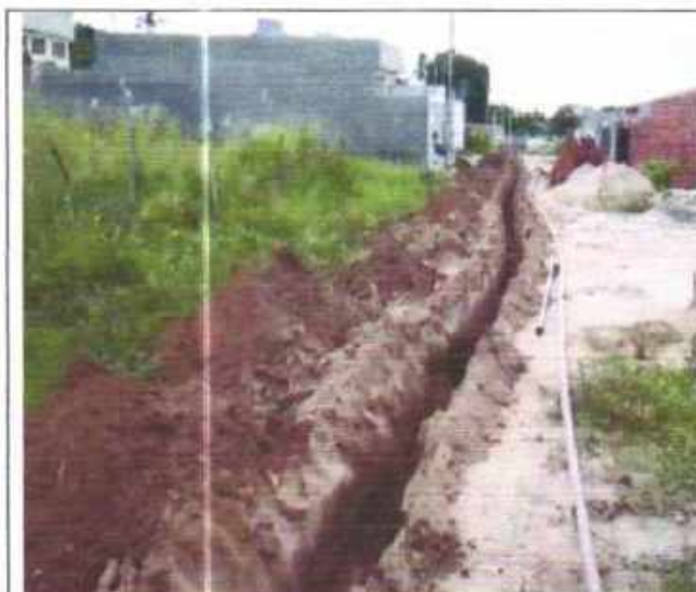
Foto 05: Implantação de sistema de abastecimento
